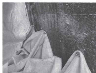
写真-25、26 アンカーボルトによる捲れ防止
