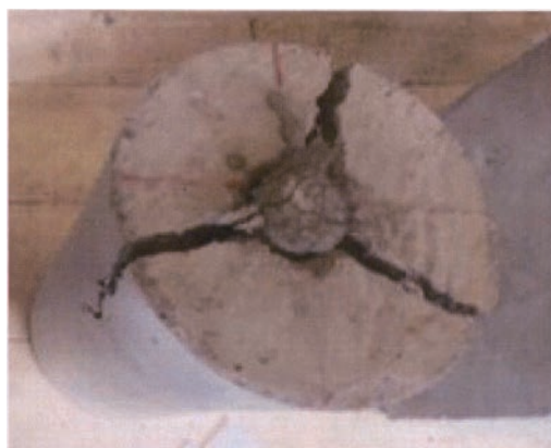
図-1 静的破砕剤によるひび割れ発生
