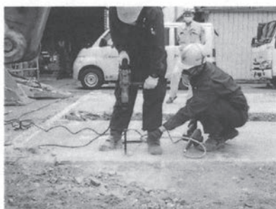
写真-13 電動ハンマドリルによる穿孔 ブロワによる孔内清掃
