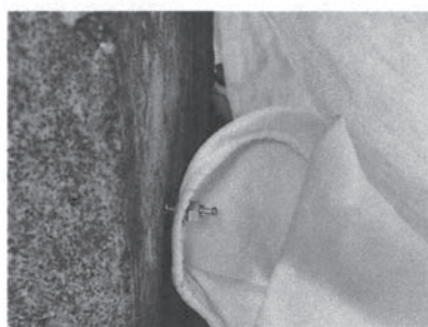
写真-25、26 アンカーボルトによる捲れ防止
