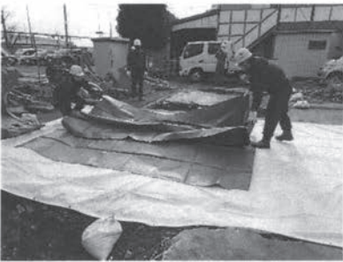
写真-4 防護養生
