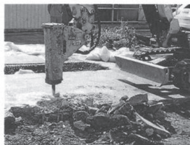
写真-16 0.637kg-CO 2 排出の作業 0.15m 3 クラスのバックホー 3.7分間のハツリ作業
