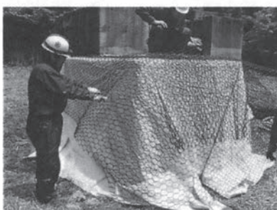
写真-32, 33 高耐久ポリエステルネット（素線線径：3mm）
