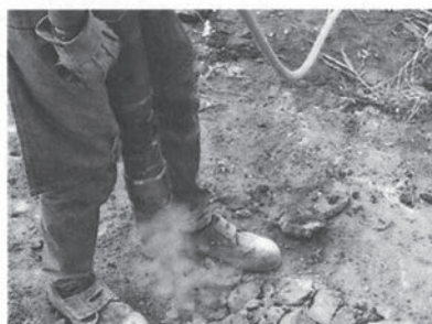
写真-15 0.637kg-CO 2 排出の作業 30HPクラスのコンプレッサー 6分間のハツリ作業
